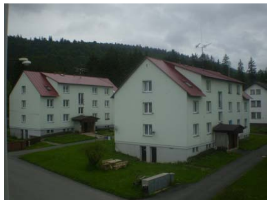
Obecní domy čp.4 a čp.5 po rekonstrukci střech
