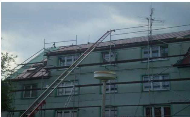
Obecní dům čp.2 v rekonstrukci střechy.
